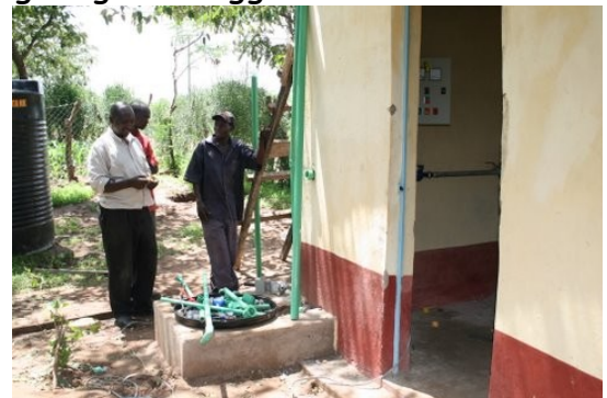
Siste finish på vannanlegget
